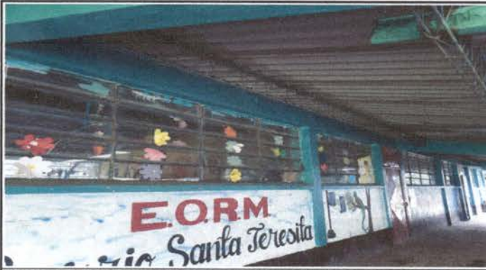
Foto1: Fabricación e instalación de balcones de hierro en ventanas.
