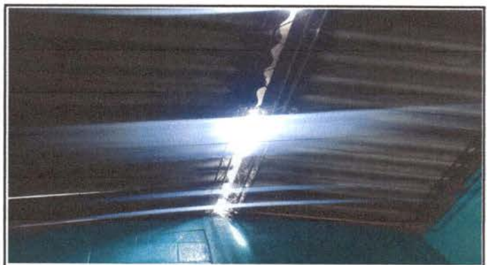
Foto 4: Cambio de techo por lamina Aluzinc calibre 26, en aula .
